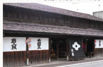
寛永元年(1624年)創業の老舗。店舗兼作業場は会津最古の商家建築。
